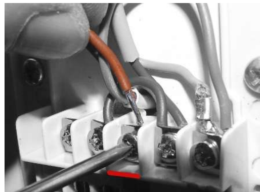
A barna vezetéket illessze be az „L” jelű sorkapocsba és rögzítse.
